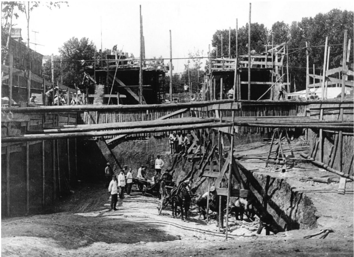
Початок будівництва електрокорпусу у 1928 р.
